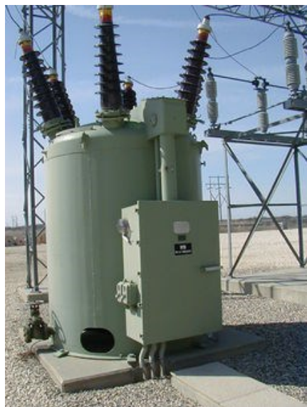
Figura 26 Interruptor en aceite para 66 kV
