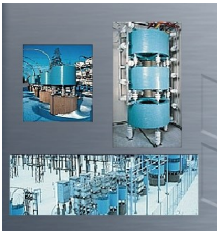
Figura 13 Reactor limitador de corriente.
