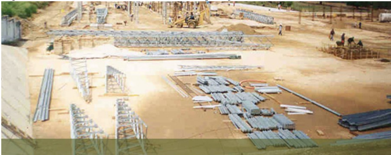
Figura 24: Estructura Mayor en fase de Montaje
